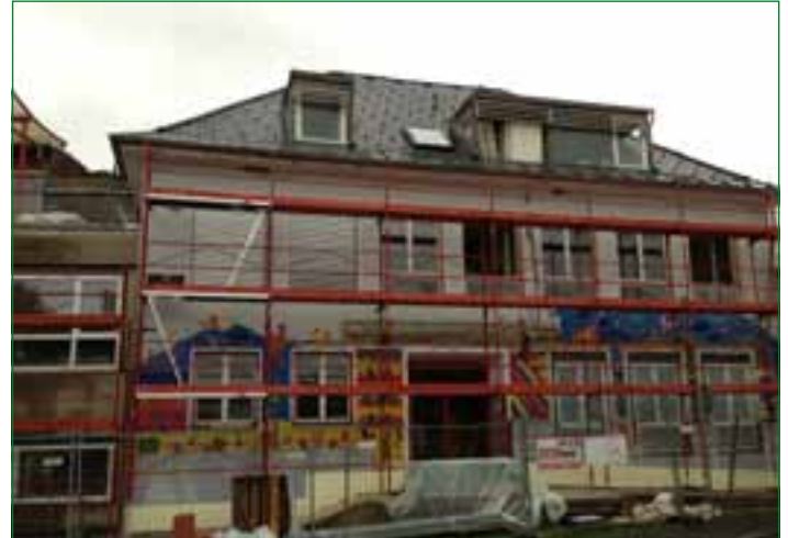
Zu (um eine Woche verschobenen) Schulbeginn wird die Fassade der Volksschule schon im neuen Glanz erstrahlen. Auch die Klassenräume sind bis dorthin fertiggestellt.
